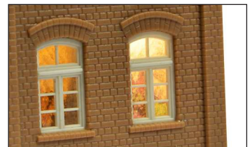
8. Dieses Bild zeigt die bessere Wirkung des mit Laibung versehenen Fensters (links). Picture shows the better method using embasure (left window).
