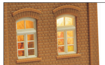
8. Dieses Bild zeigt die bessere Wirkung des mit Laibung versehenen Fensters (links). Picture shows the better method using an embossed frame (left window).
